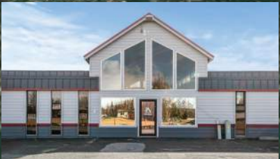
3161 E PALMER-WASILLA HWY
